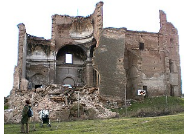
Estado de las ruinas tras el derrumbe
